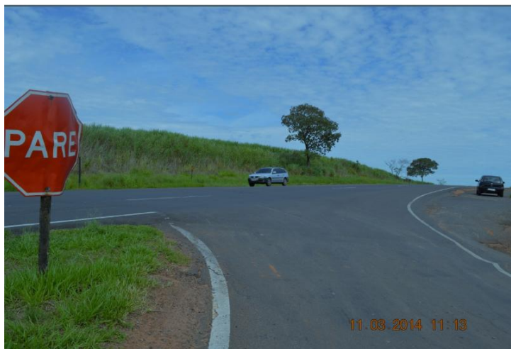
Foto nº 04 – Detalhe da restrição de visibilidade na interseção à direita ao longo da SP 294, sentido Junqueirópolis à Irapuru, do motorista oriundo do Bairro Salgado Filho, ao cruzar a rodovia.
