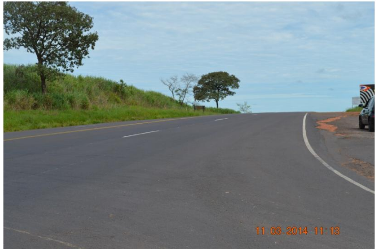
Foto nº 05 – Detalhe da pouca visibilidade na interseção à direita ao longo da SP 294, sentido Junqueirópolis à Irapuru, do motorista oriundo do Bairro Salgado Filho ao cruzar a rodovia.
